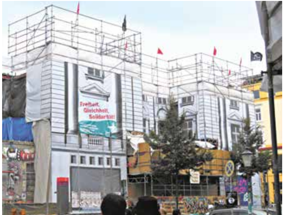
Der BUH präsentiert bei der Sanierung der Roten Flora in Hamburg.
