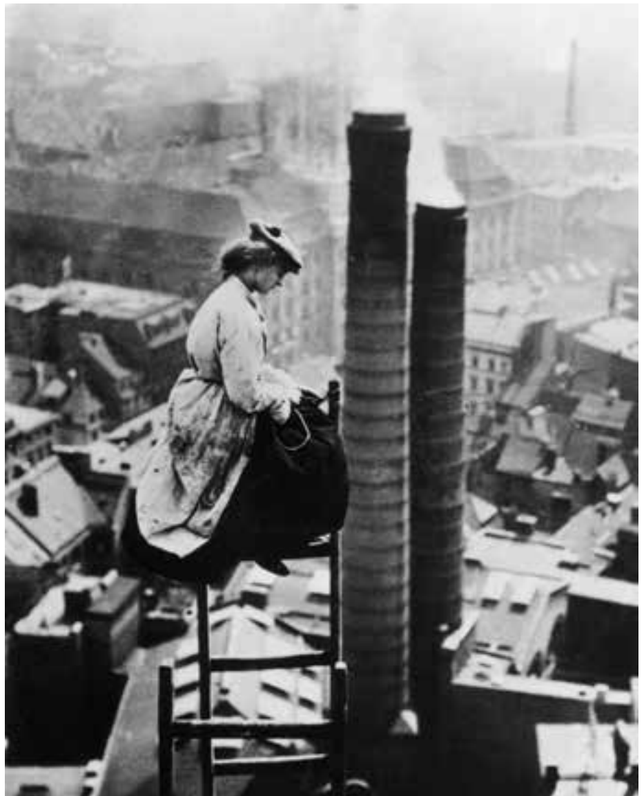
Tochter eines Berliner Maurermeisters bei Ausbesserungsarbeiten am alten Rathausturm (Berlin 1910)
